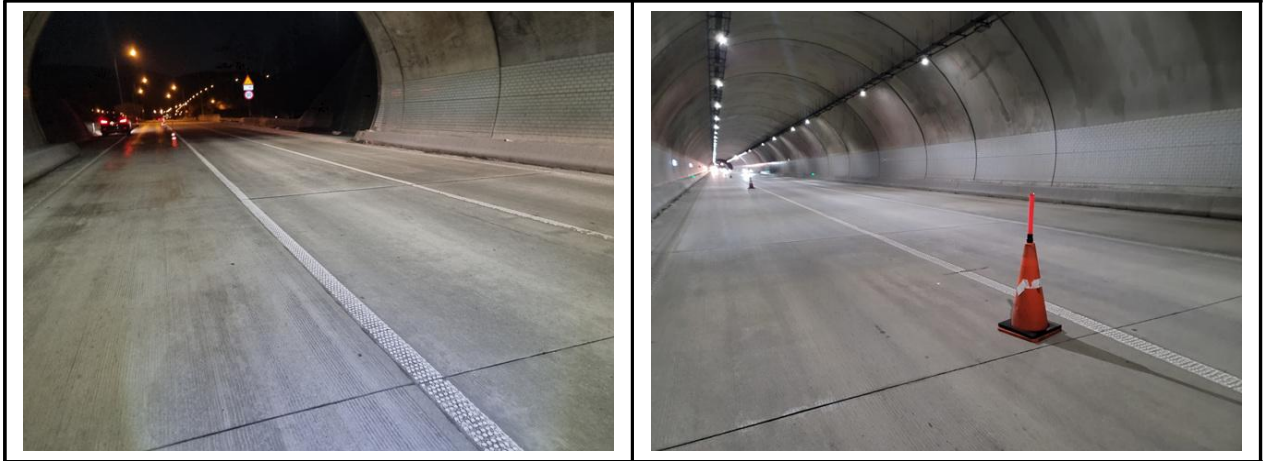
【사진 1.3.11】 포장부 전경
